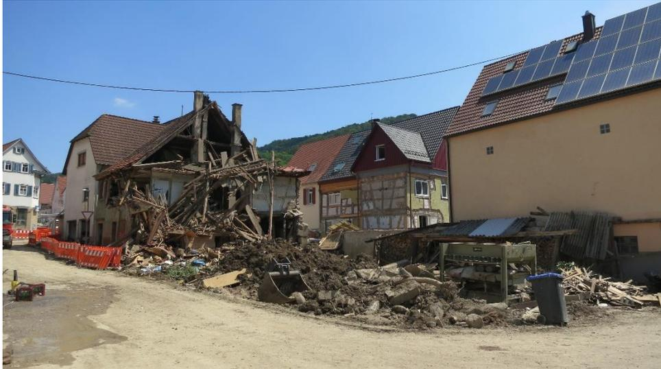
**Abbildung 13: Strömungsangriff und Treibgutprall zerstörte Gebäude in Braunsbach.**
