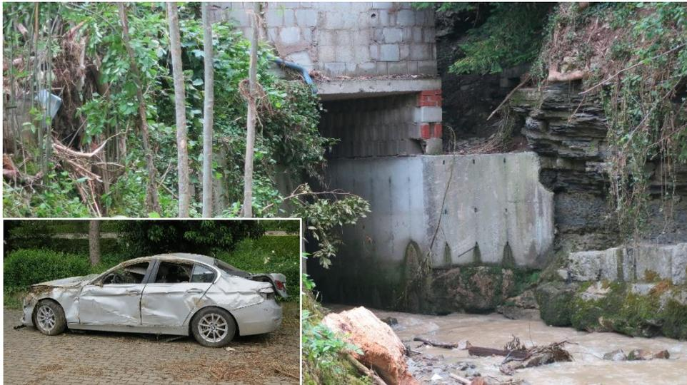
**Abbildung 17: Einlass zur Unterführung eines Gebäudes, der beim Hochwasser durch ein querstehendes KFZ verlegt wurde.**
