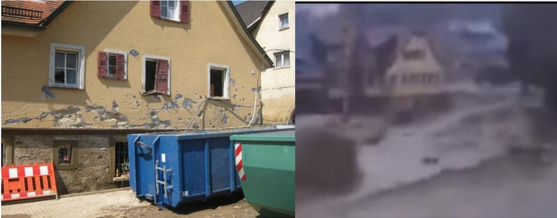
**Abbildung 11: Schaden im Erdgeschoss (Souterrain/Tiefparterre) und 1. Obergeschoss (links); Strömungssituation während des Ereignisses mit lokal stark variierenden Wasserständen (rechts).**
