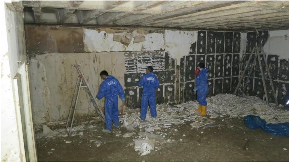
Abbildung 18: Sanierungsarbeiten an einem Gebäude in Künzelsau. Aufgrund der Feuchteschände ist in vielen Fällen ein Rückbau der Keller- und Erdgeschosse in den Rohbauzustand erforderlich.
