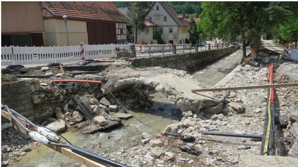
**Abbildung 14: Straßenschäden nach Umströmung einer Brücke in Steinkirchen.**
